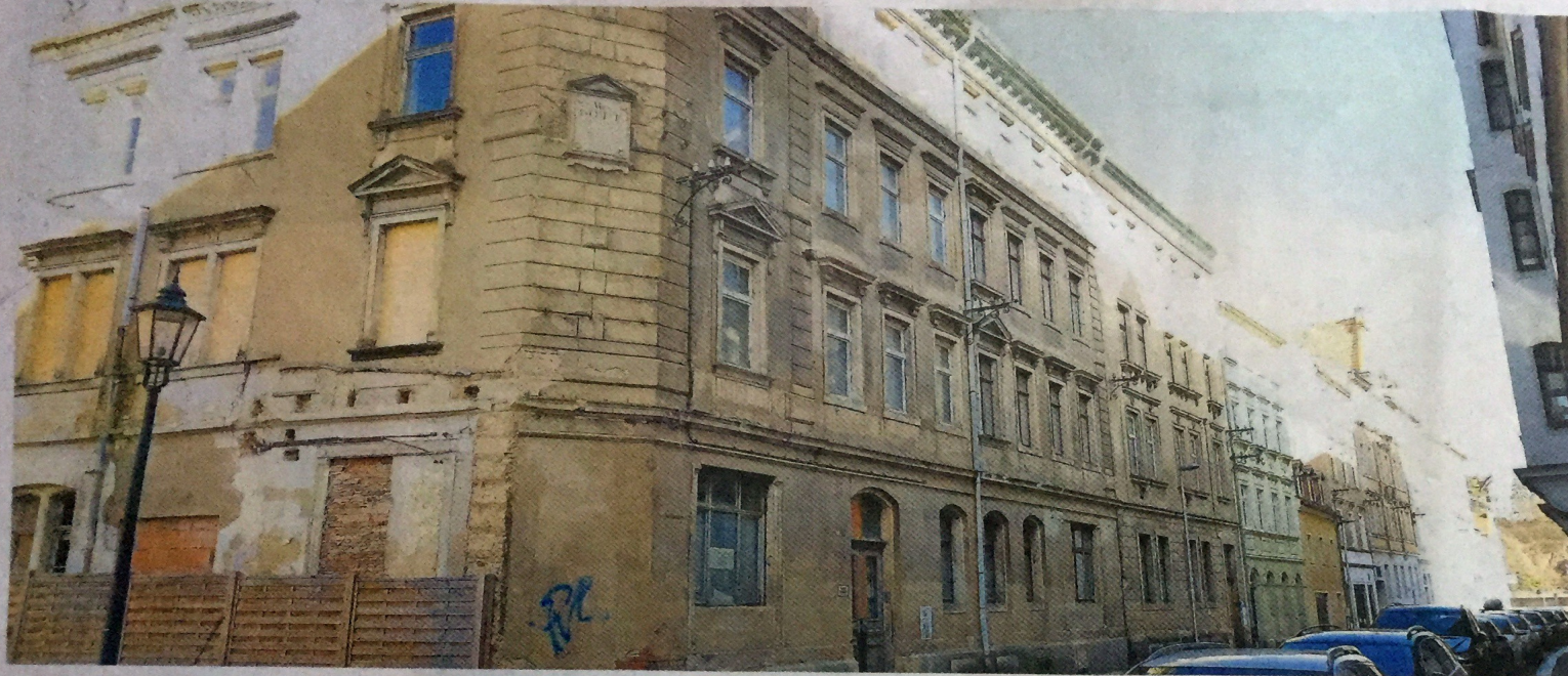
Die drei Häuser in der Fährmannstraße mit einem grünen Netz an der Dachkante sollen nach Willen der Stadtverwaltung abgerissen werden.
